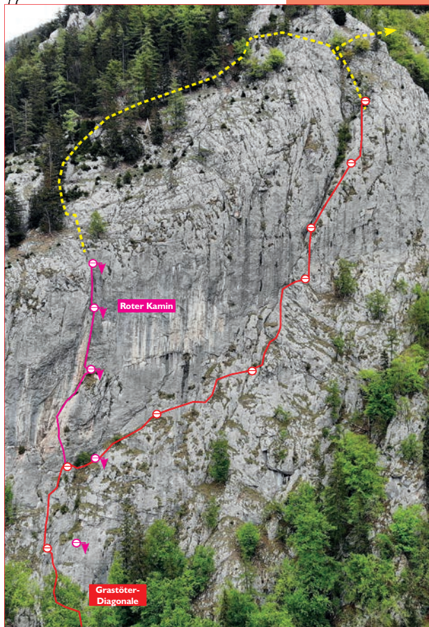
Bild/Pic: Der Rampenwulst mit den beiden Routen.
