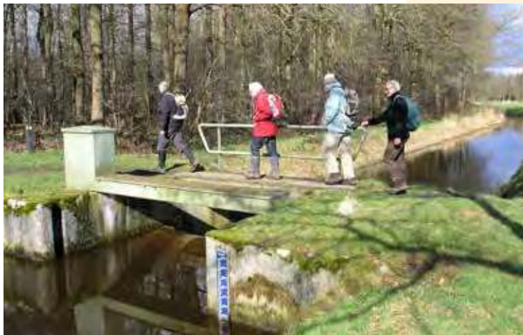
Stuw in de Reusel
